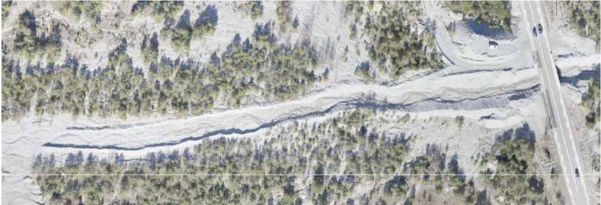
Figure 4 : Vue aérienne secteur aval RN94 (VR3D, février 2024)
