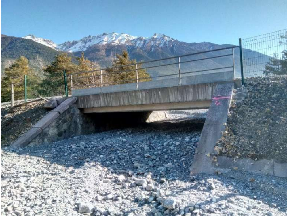
Figure 10 : pont SNCF en Février 2024
