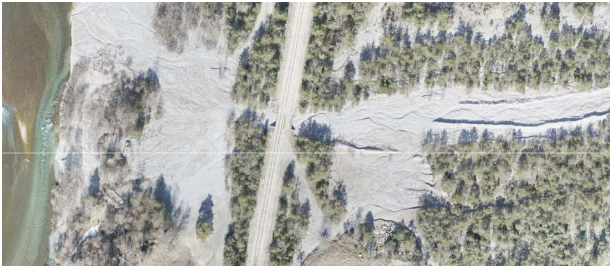
Figure 5 : Vue aérienne secteur pont SNCF (VR3D, février 2024)
