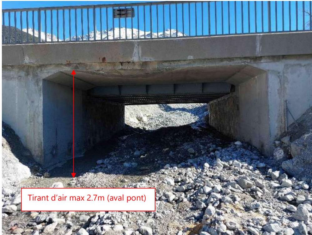
Figure 8 : Ouvrage de la RN94 en février 2024 (face aval)
