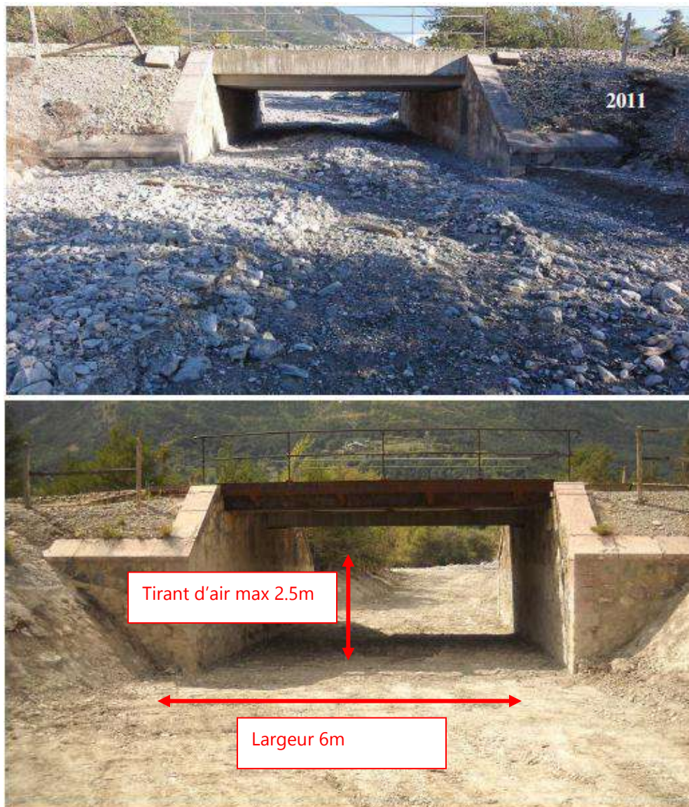
Figure 9 : Photos du pont SNCF en 2011, avant et après curage (Source : étude ETRM 2020)
