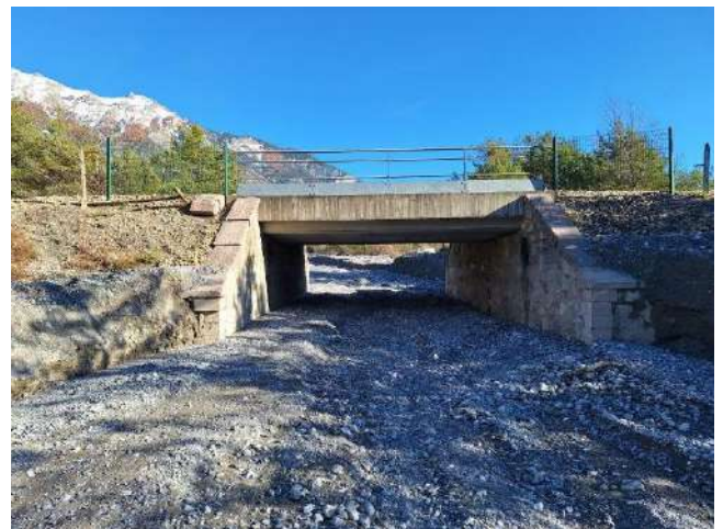
Figure 17 : Pont SNCF depuis l’aval, après travaux - Octobre 2024 (Photo Nov. 2024 SNCF)
