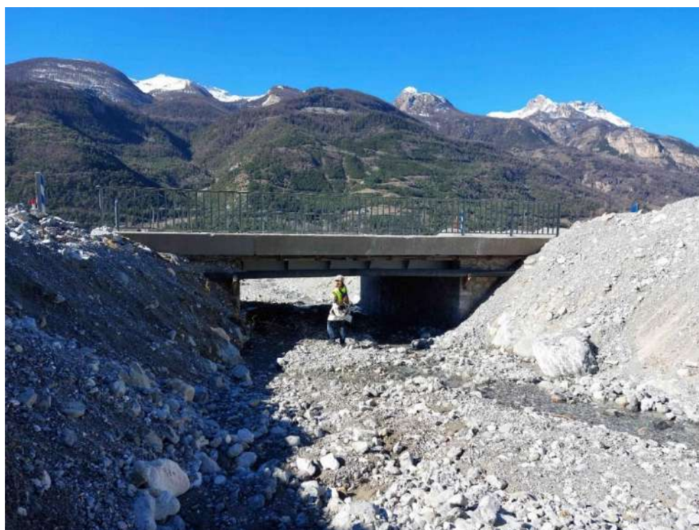
Figure 7 : Ouvrage de la RN94 en février 2024 (face amont)
