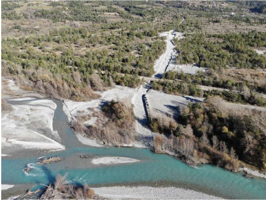
Figure 15 : Vue aérienne de la confluence Merdanel – Durance depuis la Durance après travaux d’Octobre 2024 (Photo Nov. 2024 SNCF)
