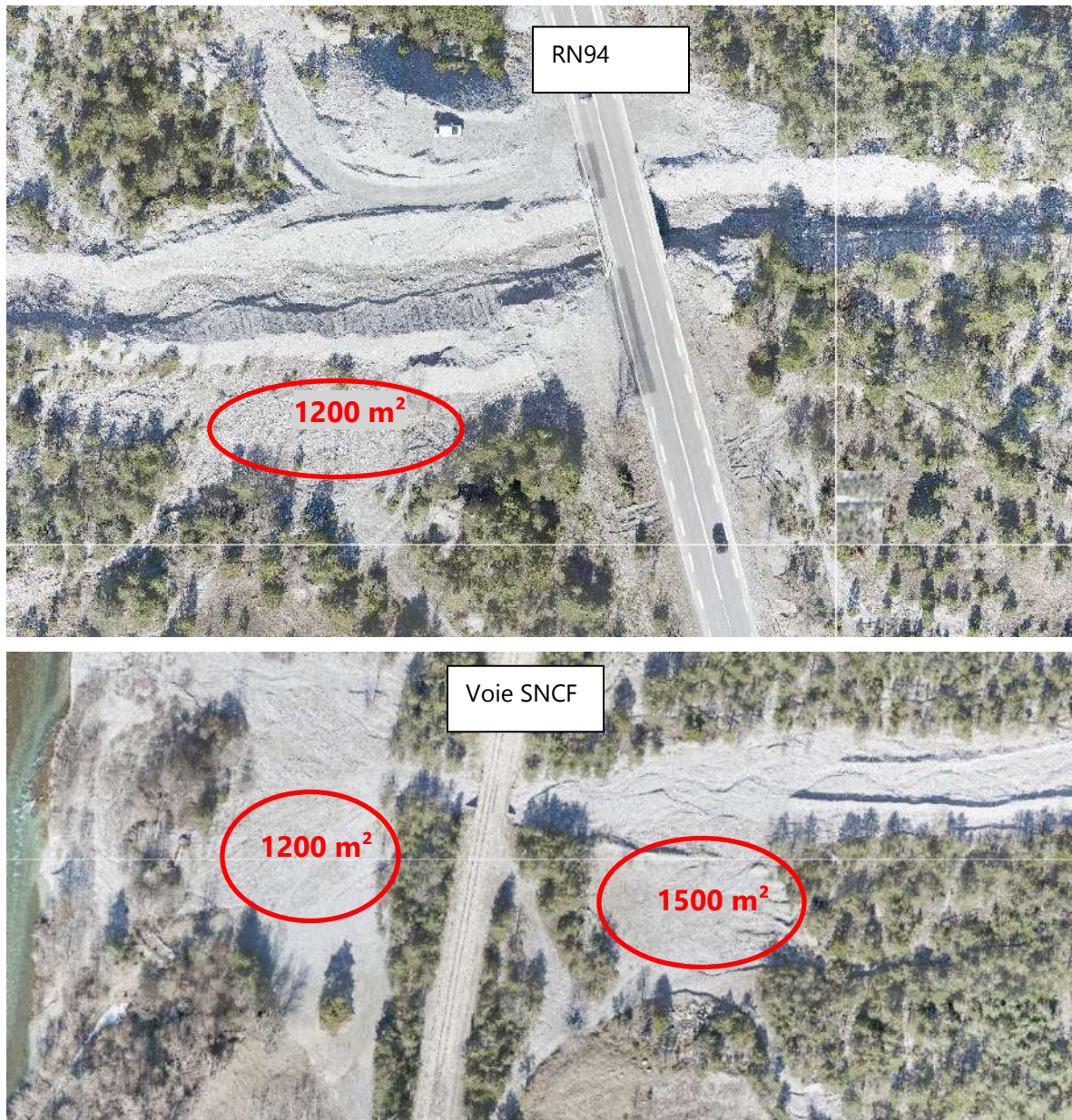
Figure 25 : Localisation des aires de stockage temporaire de matériaux (photos VR3D, février 2024)
