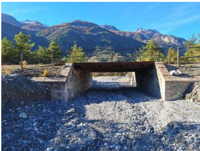
Figure 16 : Pont SNCF depuis l’amont, après travaux - Octobre 2024 (Photo Nov. 2024 SNCF)
