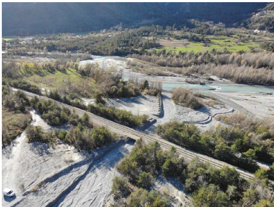
Figure 14 : Vue aérienne de la confluence Merdanel – Durance depuis l'amont, après travaux d'Octobre 2024 (Photo Nov. 2024 SNCF)
