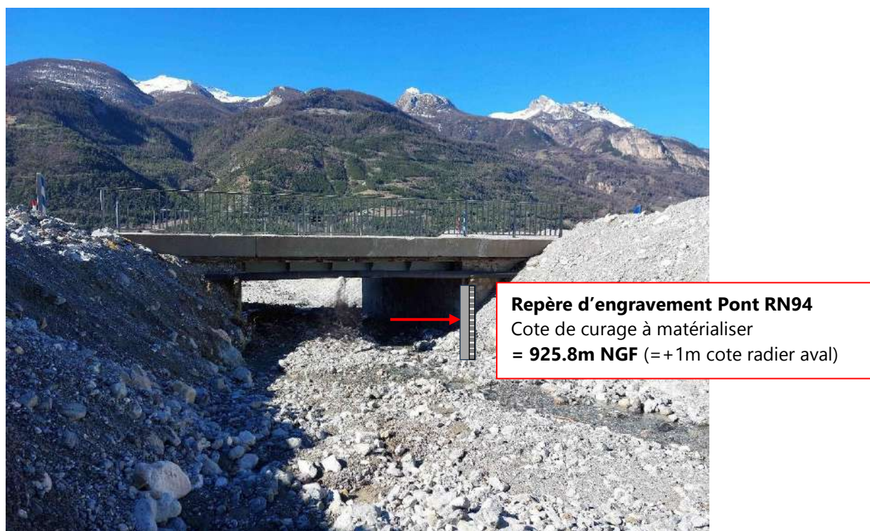
Figure 53 : Localisation des repères préconisés – face amont du pont de la RN94
