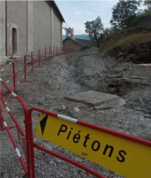
Les travaux consistent en la réfection des réseaux d'eau potable qui ont plus de 70 ans d'assainissement par la Communauté de Communes et la création d'un réseau pluvial pour récupérer les eaux de ruissellement et mettre fin notamment aux infiltrations constatées sur le mur de l'église.
