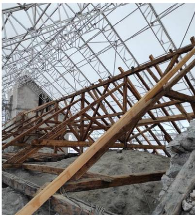
L'échafaudage a été installé à l'automne 2021. Le « clou du spectacle » étant la pose du parapluie, structure destinée à recevoir une immense bâche protégeant l'intégralité de l'édifice et permettant de réaliser les travaux en toute sécurité et par tous les temps (ou presque...), pose réalisée au moyen d'un hélicoptère.
