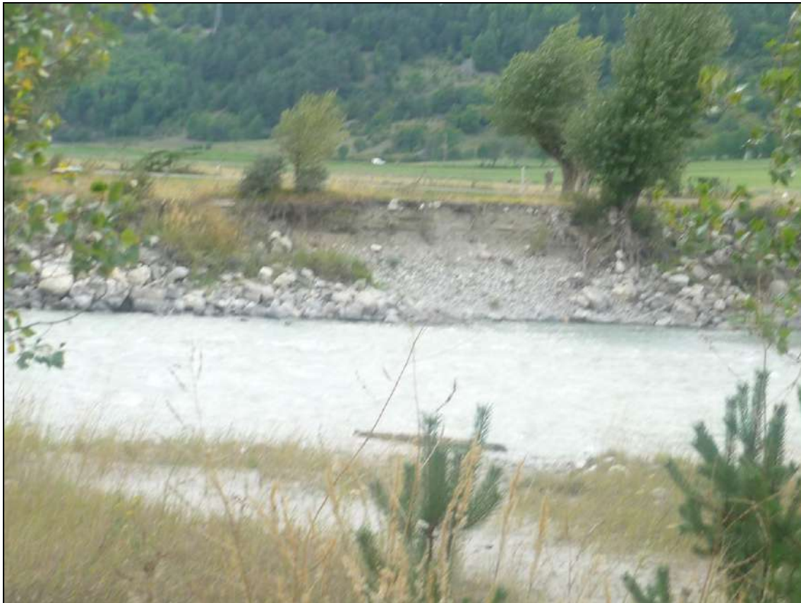
Figure 42 : Erosions de berges le long de la Durance (au niveau de Bourgea) [Source : IMS RN ]
