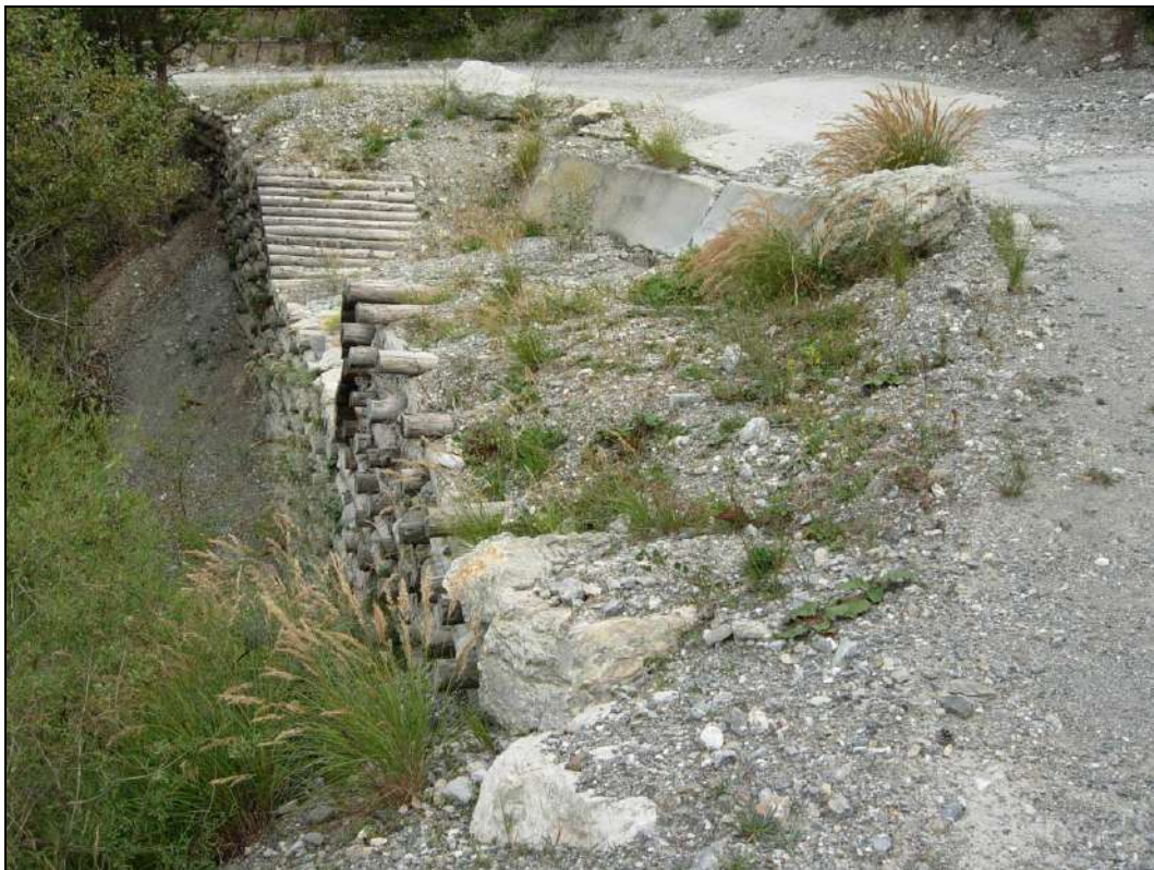
Figure 38 : Seuils en bois et béton dans le secteur de la Cabane de la Rimas [Source : IMS RN ]
