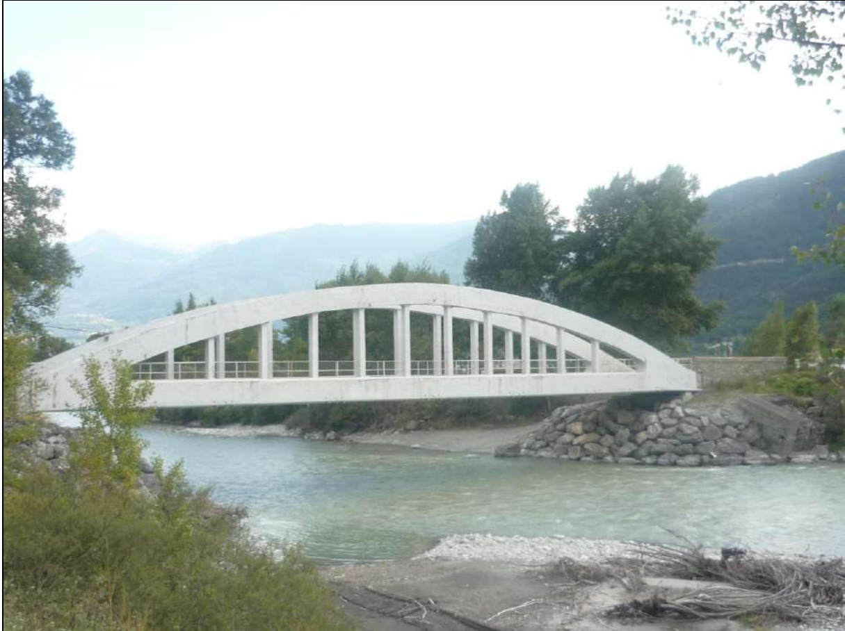
Figure 72 : Pont de Chanteloube [Source : IMS RN ]
