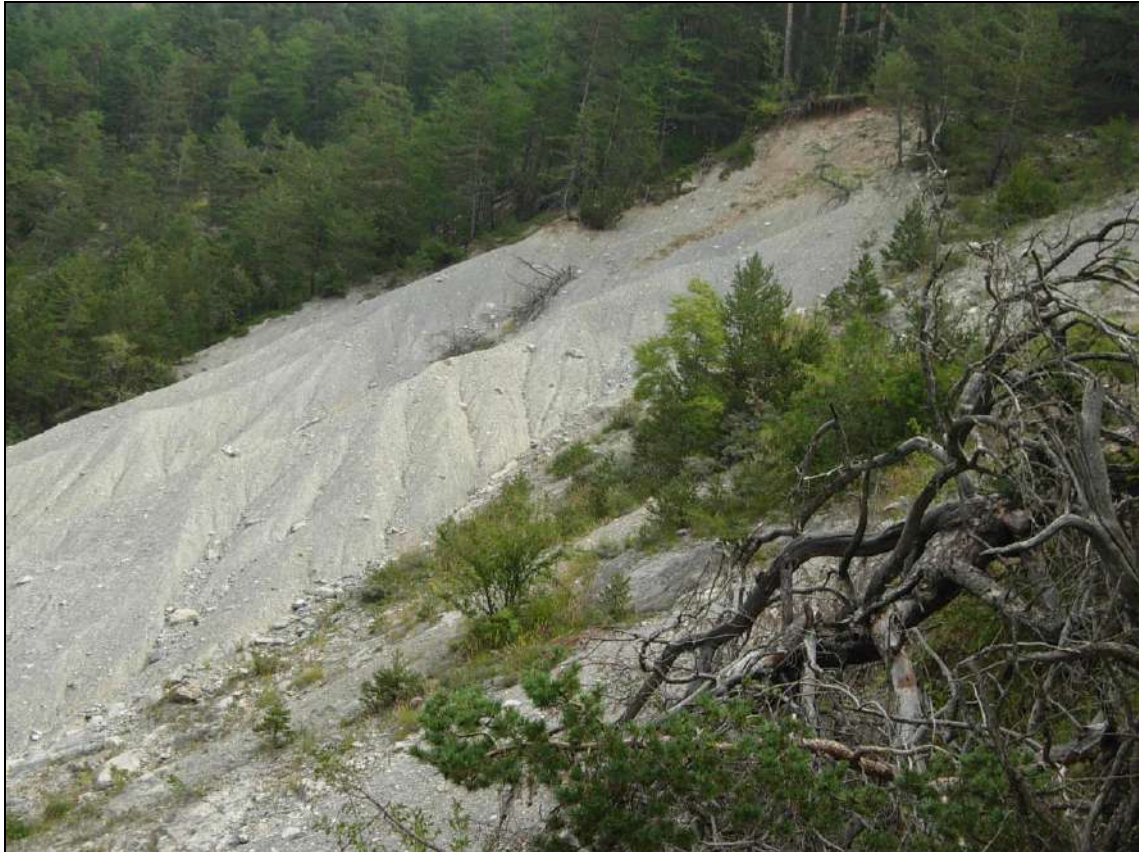
Figure 67 : Ravinement dans le secteur de la Cabane de la Rimas [Source : IMS RN ]
