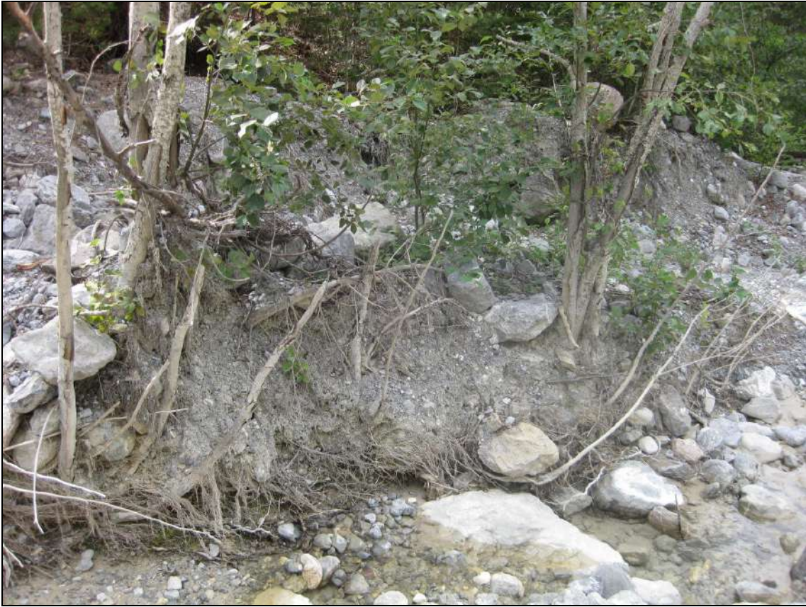
Figure 43 : Erosions de berges le long du Merdanel (au niveau des Combes) [Source : IMS RN ]
